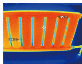
房屋暖通检测
