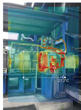
大型减速机润滑状态监测
